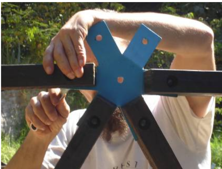
Alberto, el voluntario Italiano uniendo piezas de madera con los conectores de lámina metálica. Abril de 2007.
