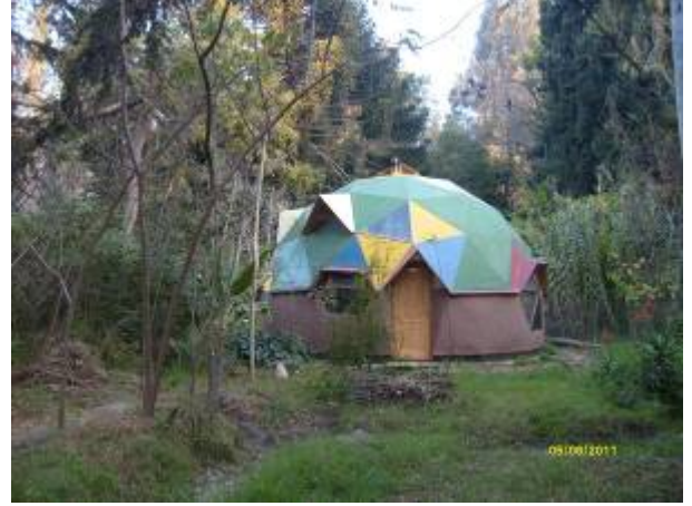
El "Planeta Domo", ya habitado en el 2009.
