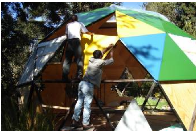
Juan y yo, montando las piezas de la cubierta.
